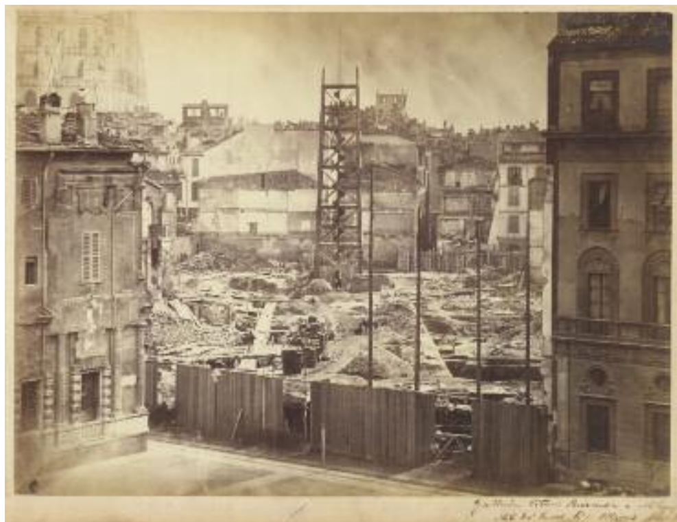
FIG. 2 - Deroche & Heyland (attribuito), «Galleria Vittorio Emanuele II a Milano. Stato dei lavori li 1° Maggio 1865», 1 maggio 1865, stampa all'albumina, inv. Albo G 107/3. Milano, Civico Archivio Fotografico
