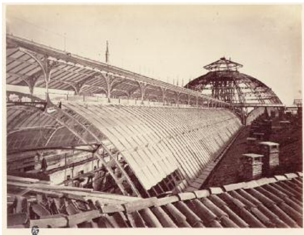
FIG. 6 - Deroche & Heyland, Tettoia della Galleria Emanuele II e cupola in costruzione , marzo-maggio 1867, stampa all'albumina, inv. Albo G 107/35. Milano, Civico Archivio Fotografico
