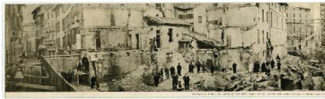
FIG. 3 - Da: Deroche & Heyland, Panoramica del cantiere della Galleria Vittorio Emanuele II , 7 gennaio 1866, inv. FM A 747. Milano, Civico Archivio Fotografico
