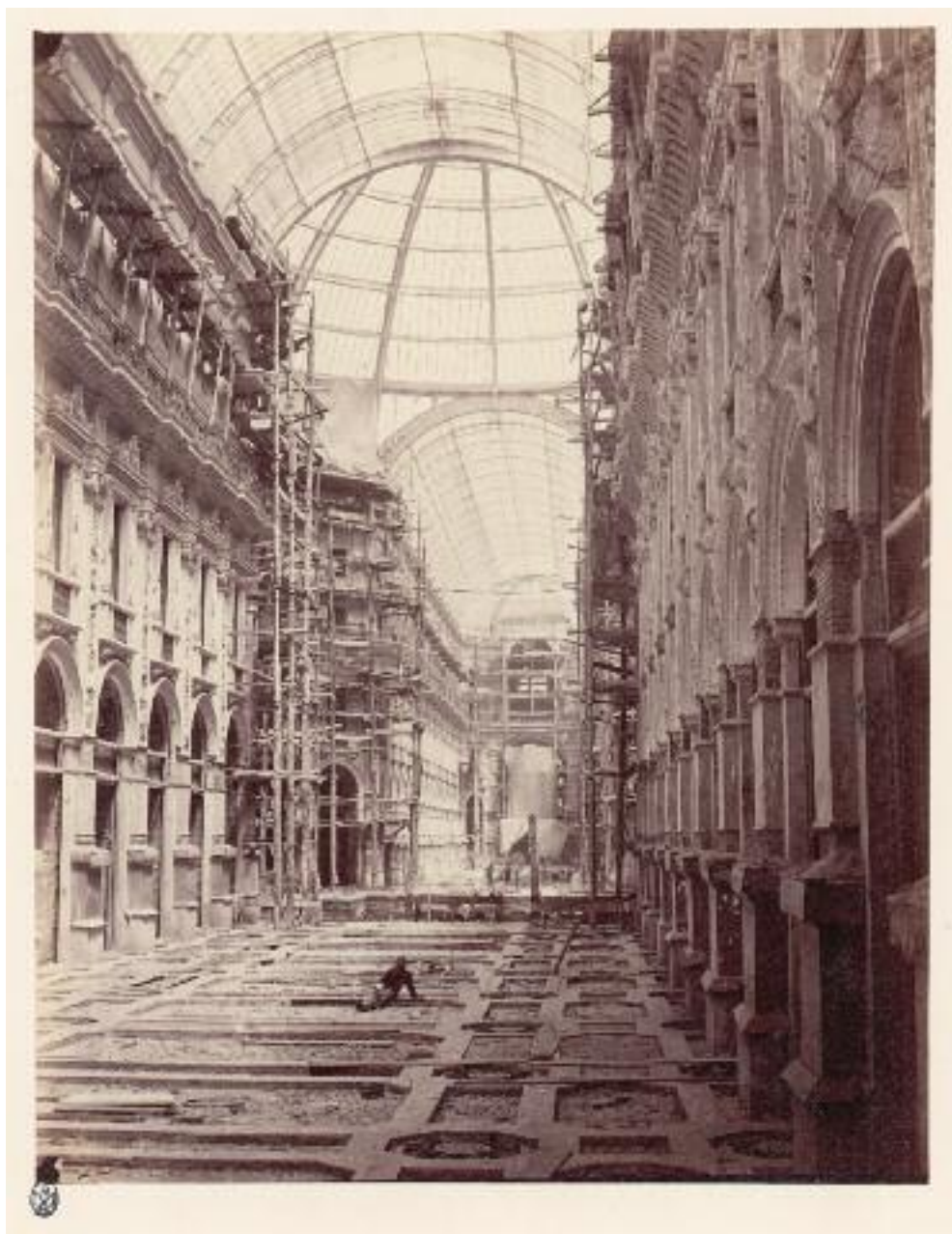
FIG. 7 - Deroche & Heyland, Galleria Vittorio Emanuele II in costruzione. Lavori per la pavimentazione , maggio-giugno 1867, stampa all'albumina, inv. Albo G 107/41. Milano, Civico Archivio Fotografico
