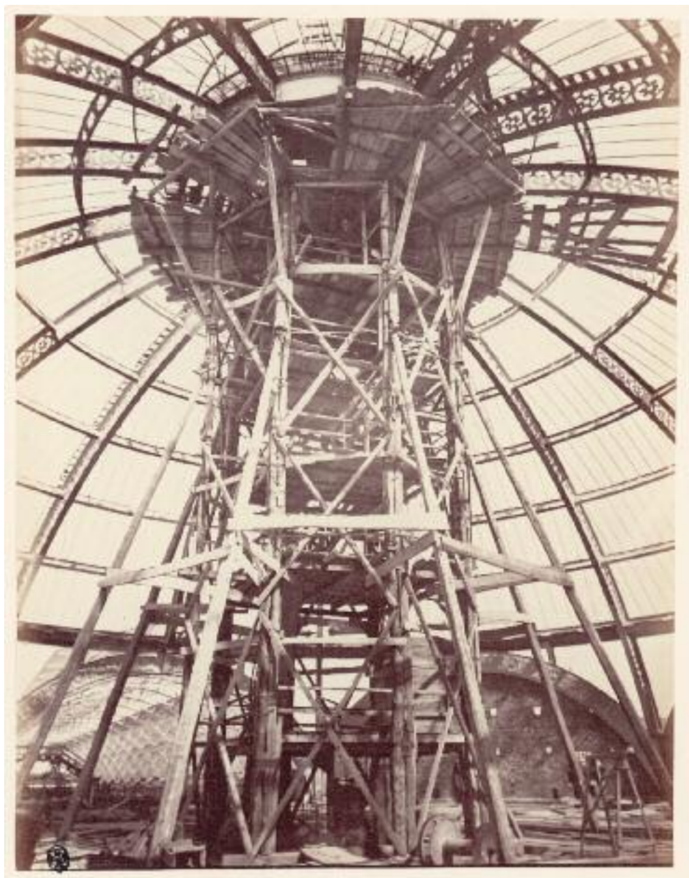
FIG. 5 - Deroche & Heyland, Particolare della costruzione della cupola della Galleria Vittorio Emanuele II , febbraio-maggio 1867, stampa all'albumina, inv. Albo G 107/31. Milano, Civico Archivio Fotografico
