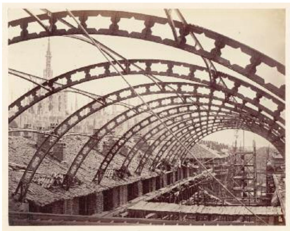
FIG. 4 - Deroche & Heyland, Costruzione della tettoia del braccio settentrionale della Galleria Vittorio Emanuele II , agosto-dicembre 1866, stampa all'albumina, inv. Albo G 107/28. Milano, Civico Archivio Fotografico
