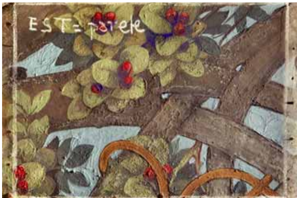
FIG. 9 - Parete sud-est, ripresa a luce radante di uno dei testimoni della ridipintura di Ernesto Rusca. Milano, Castello Sforzesco, Sala delle Asse
