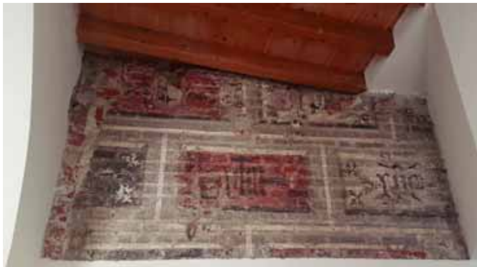
FIG. 14 - Particolare dell'antica decorazione esterna, ora locale interno al piano terreno. Milano, palazzo Carmagnola
