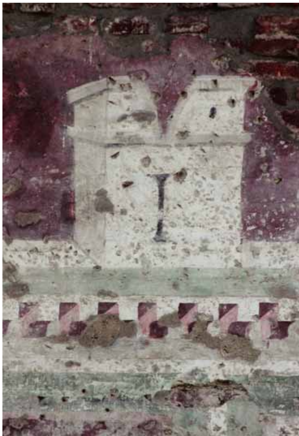
FIG. 18 - Particolare di merlo con feritoia e fascia ornamentale sottostante. Milano, Cascina Boscaiola Prima
