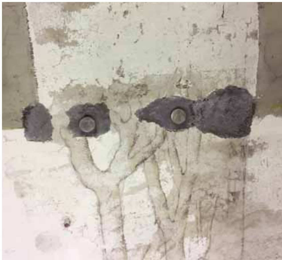
FIG. 19 - Parete sud est, i perni di aggancio dell'allestimento ligneo BBPR inseriti nell'intonaco antico dove un tassello di descialbo, svolto nel corso dell'attuale intervento di restauro, ha portato a vista il disegno preparatorio. Milano, Castello Sforzesco, Sala delle Asse
