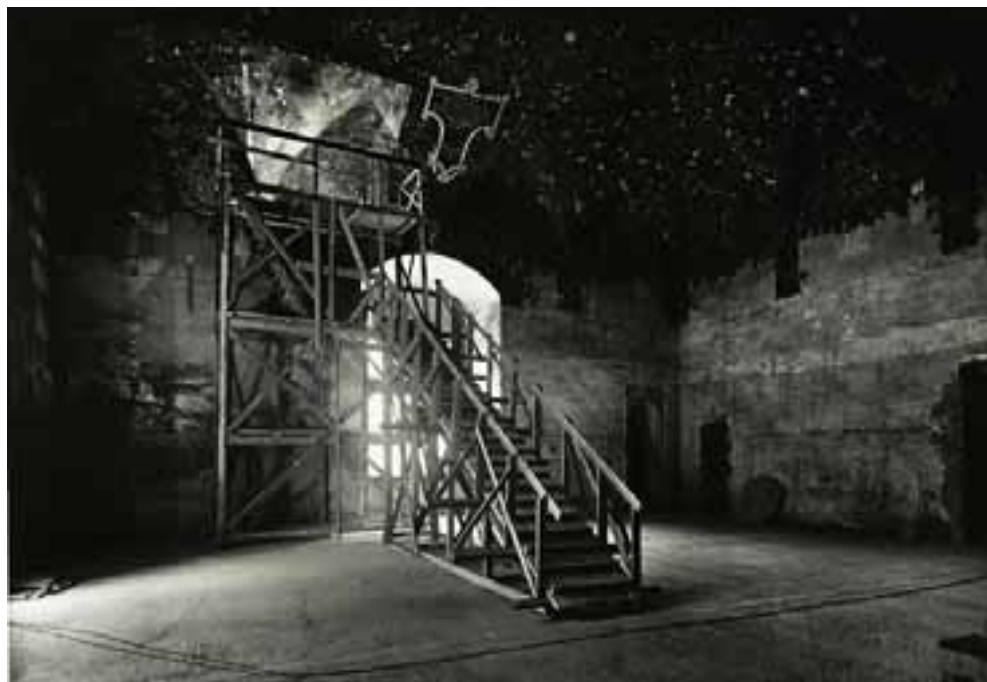
FIG. 21 - Foto Mario Perotti, Parete nord est, impalcatura di servizio per l'intervento di Ottemi Della Rotta, 1956, fondo Ottemi Della Rotta, 24.05.024. Cesano Maderno, Istituto per Storia dell'Arte Lombarda, Fototeca
