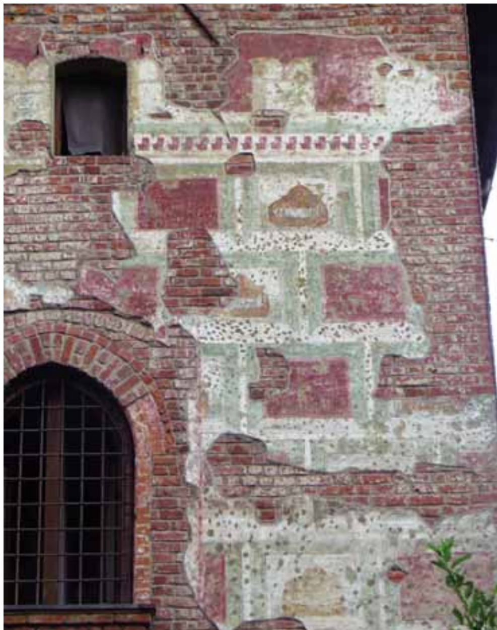
FIG. 9 - Porzione destra della facciata, particolare della decorazione a specchiature prospettiche sovrapposte con riquadri a fondo chiaro (ornati dal motivo dell'arnia) e a fondo morello. Milano, Cascina Boscaiola Prima
