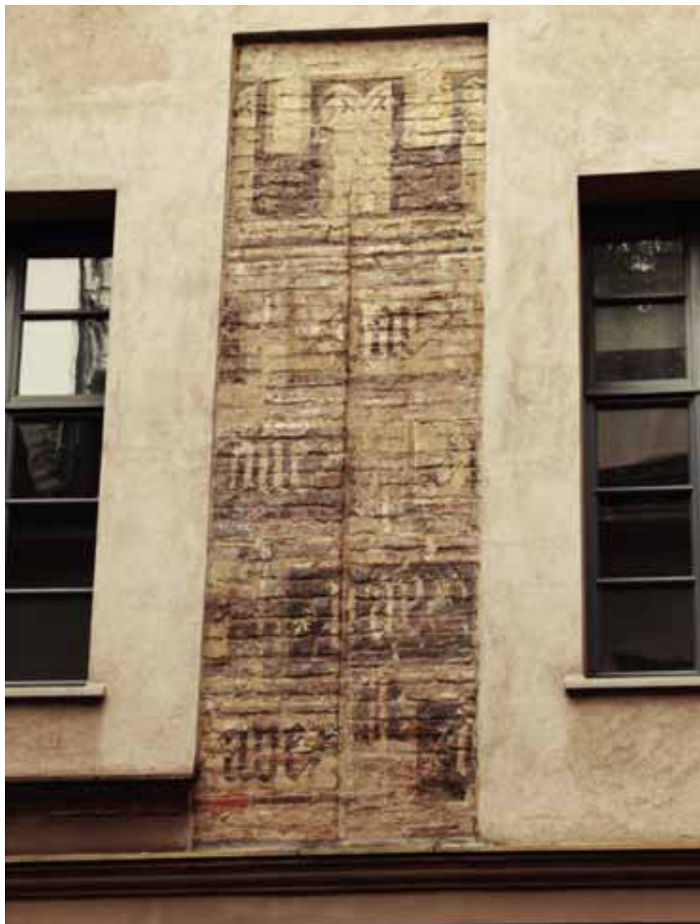
FIG. 12 - Particolare delle finte merlature. Milano, cortile di casa dei Bossi
