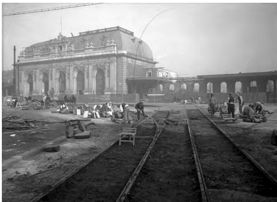
FIG. 8 - Vincenzo Aragozzini, Milano. Lavori di demolizione della vecchia stazione Centrale , post 1931, negativo su lastra di vetro alla gelatina bromuro d'argento, inv. B 4757. Milano, Castello Sforzesco, Civico Archivio Fotografico
