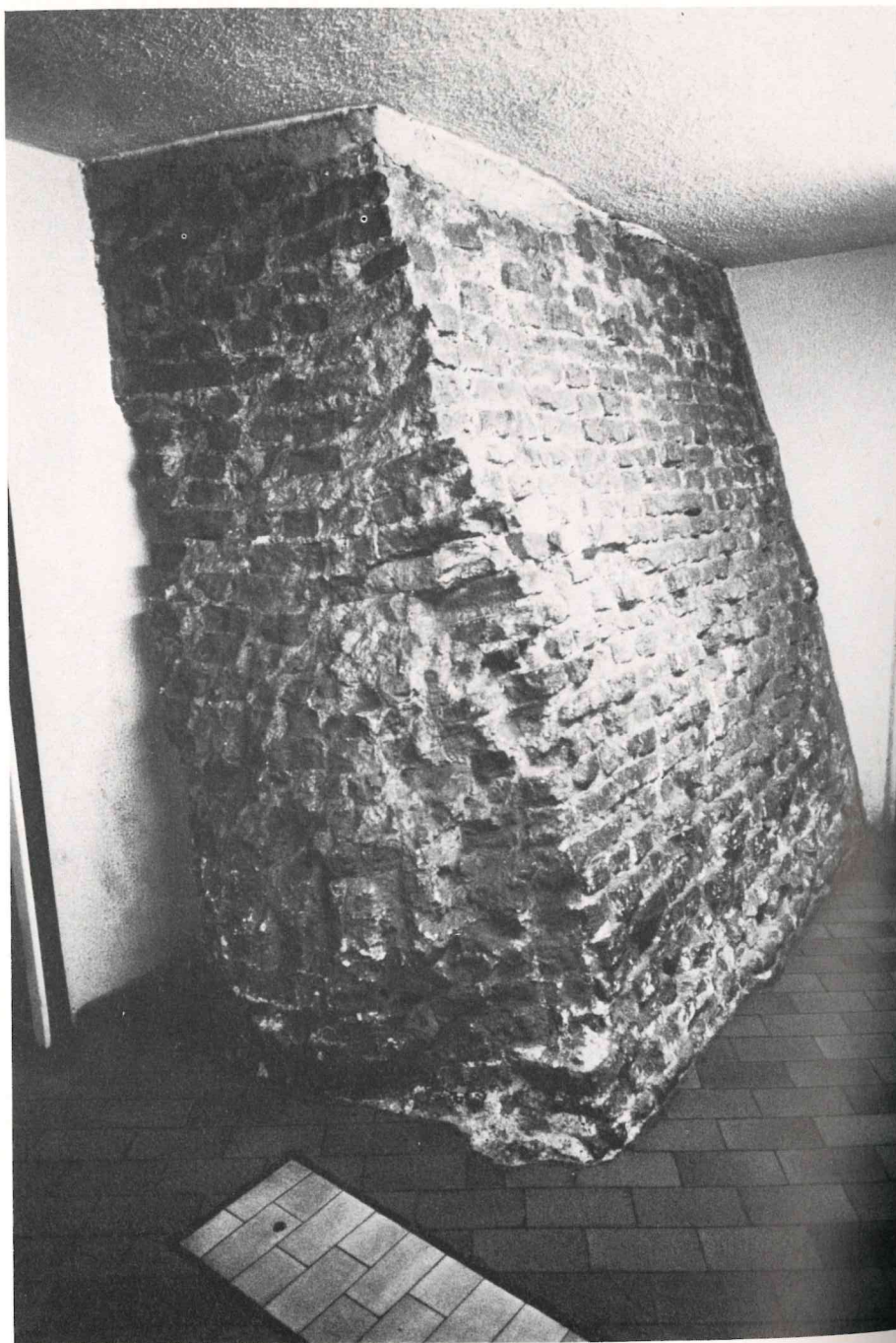
FIG. 3 - Il tratto di muraglione verso Nord-Ovest.
