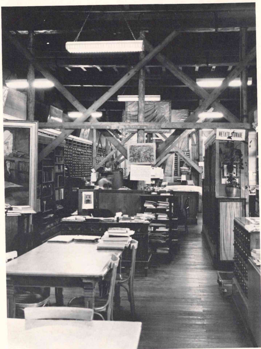
La Raccolta delle Stampe come si presentava durante il periodo in cui fu necessario puntellare il soffitto per minaccia di crollo.
