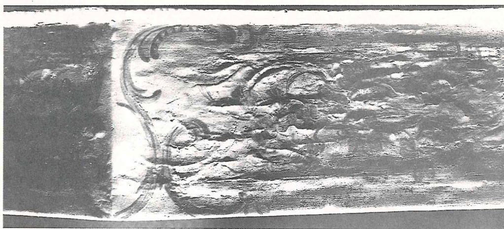
FIG. 17 - Ripresa fotografica a luce radente. Si noti l'estrema scabrosità della superficie (cretti longitudinali con sollevamento di materiale) e il particolare della decorazione sottostante.
