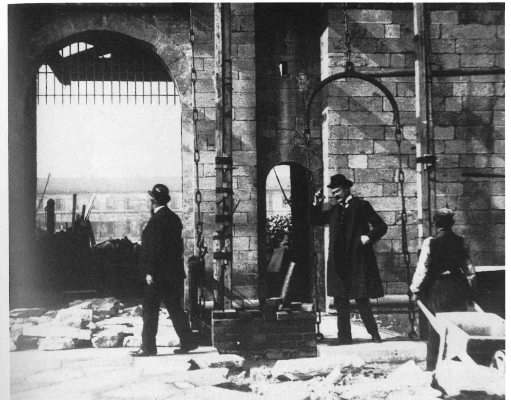
FIG. 4 - Luca Beltrami durante i restauri del Castello. Civico Archivio Fotografico, Castello Sforzesco, Milano.
