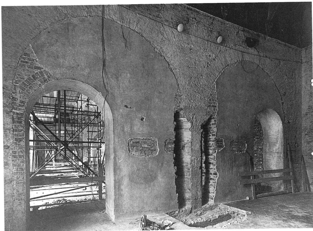
FIG. 3 - Castello Sforzesco. Pianterreno della Corte Ducale: l'intervento di consolidamento strutturale nella Galleria delle sculture.
