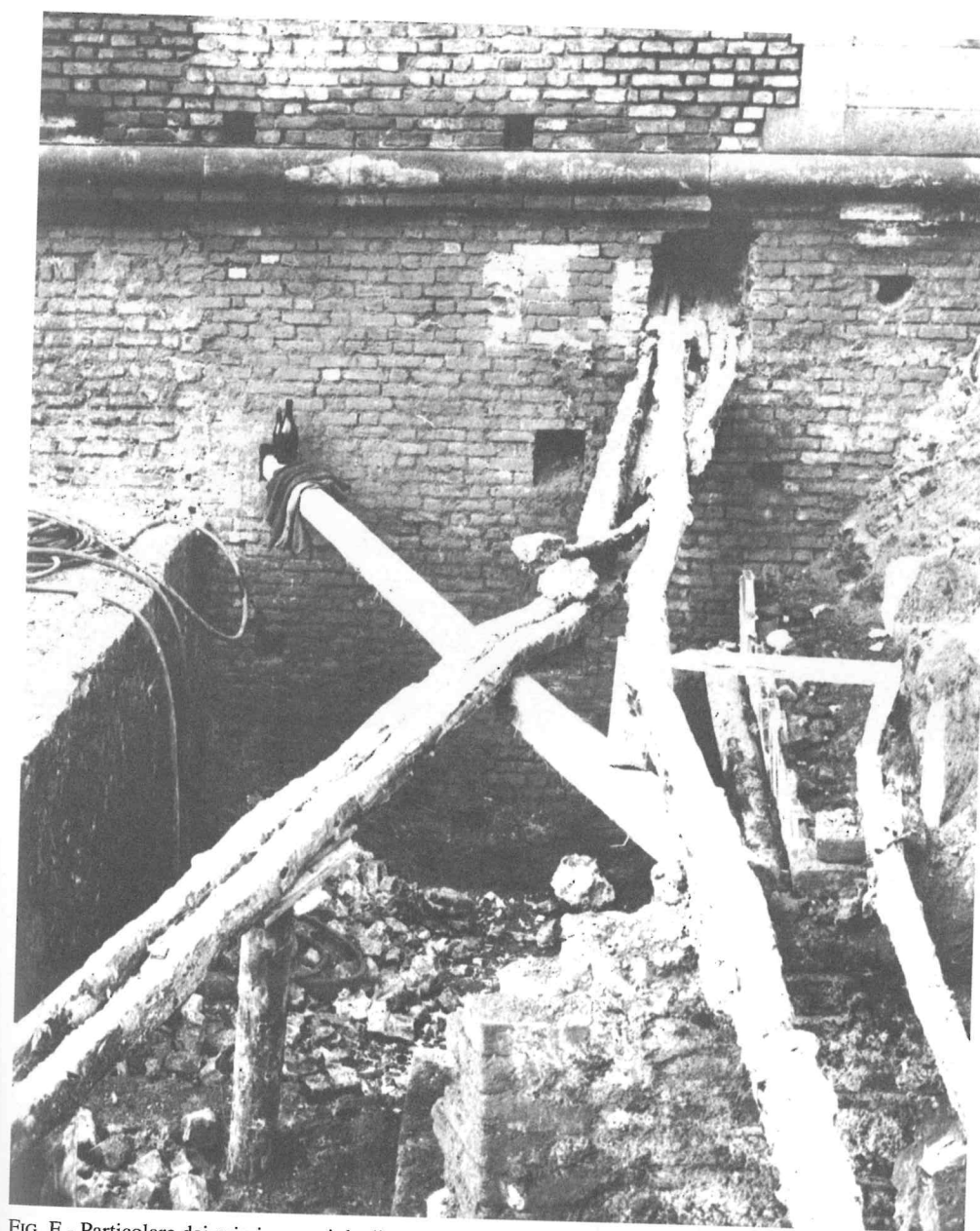
Fig. F - Particolare dei primi assaggi degli scavi per la realizzazione del tunnel della Linea 1 della Metropolitana Milanese: sulla sinistra si riconosce il muro meridionale del rivellino, che sarà smontato nel proseguo dei lavori. Civico Archivio Fotografico di Milano, cart. Scavi della Metropolitana, circa 1959-61.
