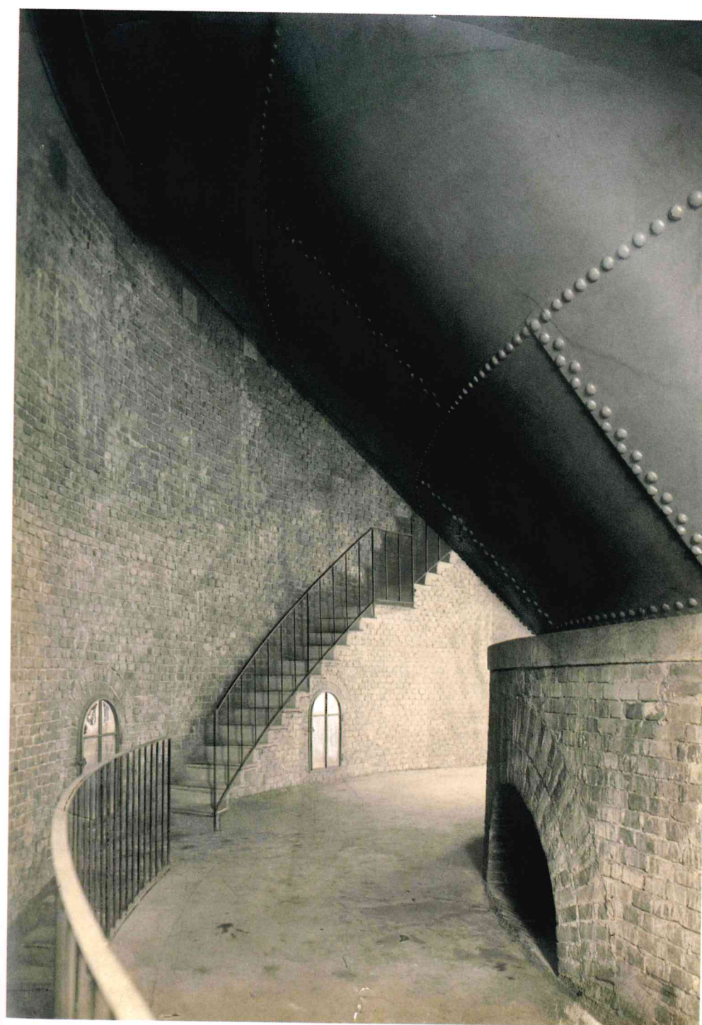
FIG. 7 - Il muro di appoggio del serbatoio in ferro nel Torrione Est e il camminamento per l'ispezione.
