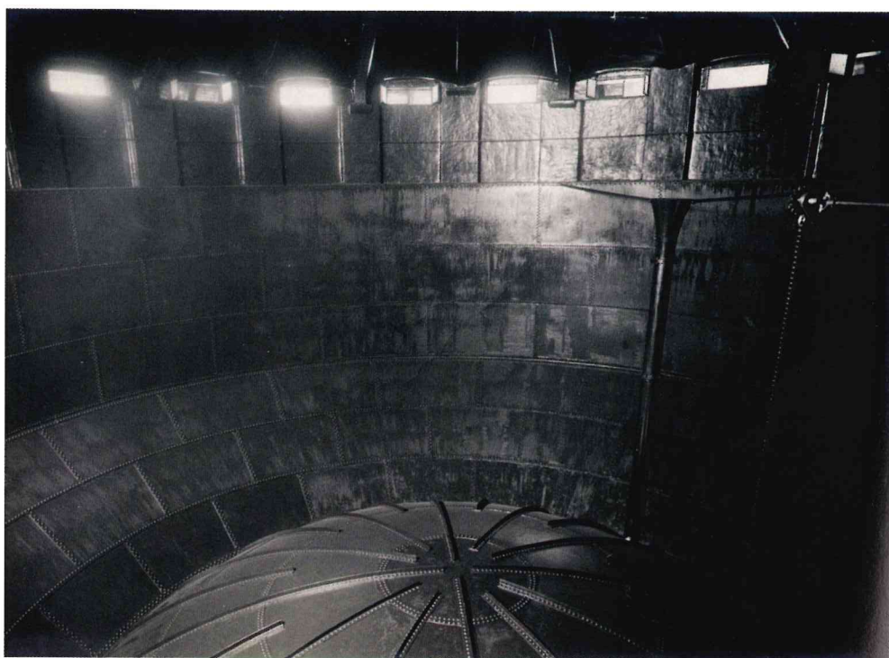
FIG. 8 - L'interno del serbatoio in ferro nel Torrione Est a lavori terminati.
