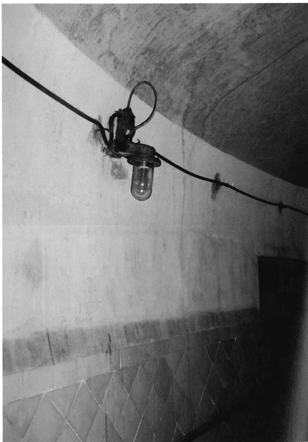
FIG. 17 - Il rivestimento interno in piastrelle e l'impianto elettrico originale, nella parte superiore del serbatoio in cemento armato del Torrione Sud.
