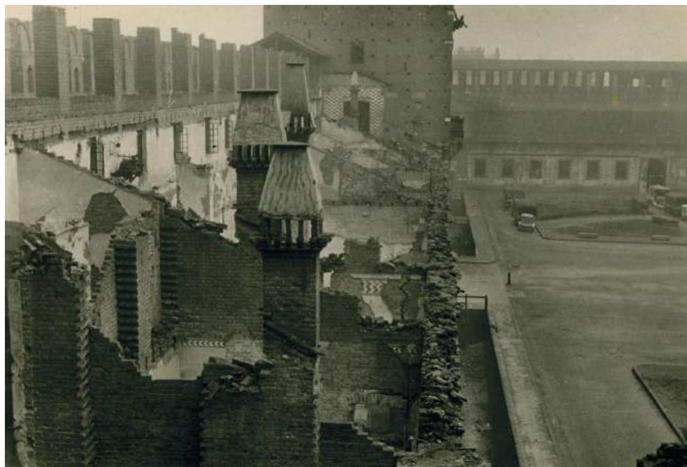
FIG. 10 - Fotografo non identificato, Veduta della cortina sud est e della Piazza d'Armi del Castello Sforzesco dopo i bombardamenti del 1943 , 1943, gelatina bromuro d'argento su carta, inv. FM MIB 607. Milano, Castello Sforzesco, Civico Archivio Fotografico
