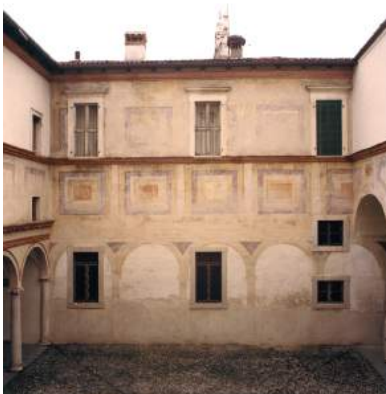
Fig. 2 – Parete meridionale del chiostro d'ingresso di San Faustino.
